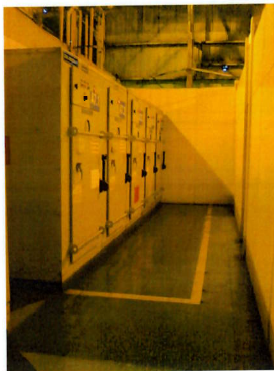
Figura 7: Demarcação de Zona Livre em frente de painéis elétricos. Fonte: Arquivo Pessoal
